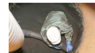
● 劣化した活性炭を吸引
